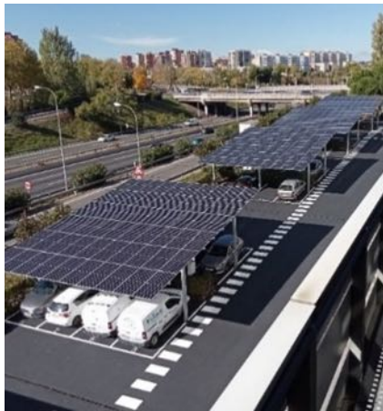
EDIFICIO IRIS MADRID
